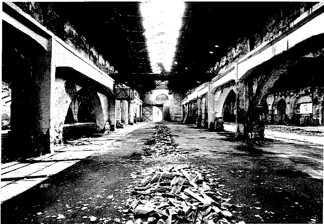
Stabilimento metallurgico Corradini. Interno del laminatoio con le tre ampie navate spartite da arconi in muratura e coperture a tetto su capriate in ferro. Una quarta navata fu demolita negli anni '20 con il potenziamento della vicina linea ferroviaria. (foto Gabriele Basilico)
